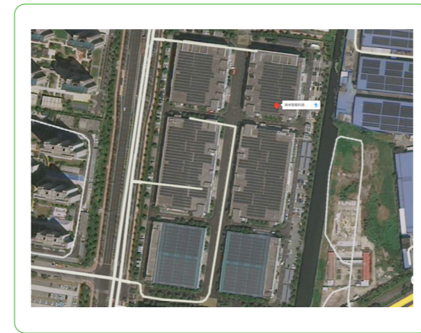
商米制造工厂屋顶太阳能光伏板
